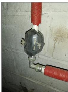
Construite en 1964, cette grande demeure avait un réseau de tuyaux qui devait être entartré et, afin de ne pas « décruster » exagérément les dépôts de calcaire, ce qui peut amener de nombreuses fuites, j'ai installé un système PRO CALC dont voici une photo très récente.
